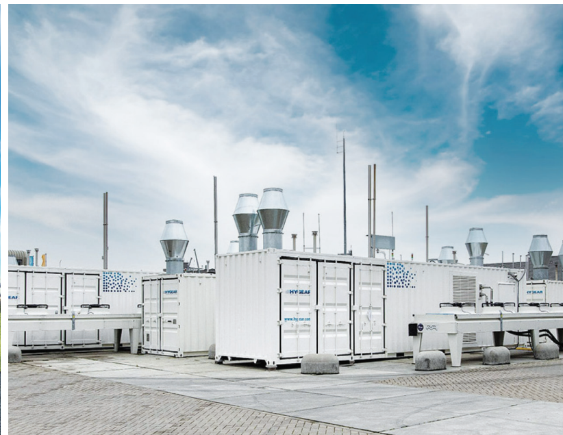
Solution de production sur site d'hydrogène
